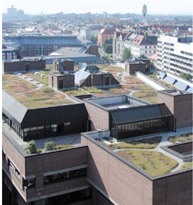
Die fünf Teilflächen des Daches wurden, nach Abschluss der Arbeiten mit Flüssigkunststoff, begrünt.
