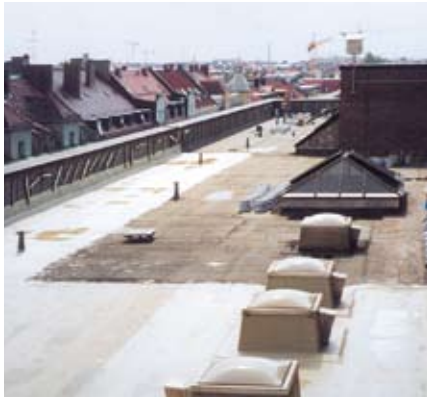
Die alte Elastomer-Bitumenschweißbahn konnte ohne Grundierung mit Triflex DS überarbeitet werden.
