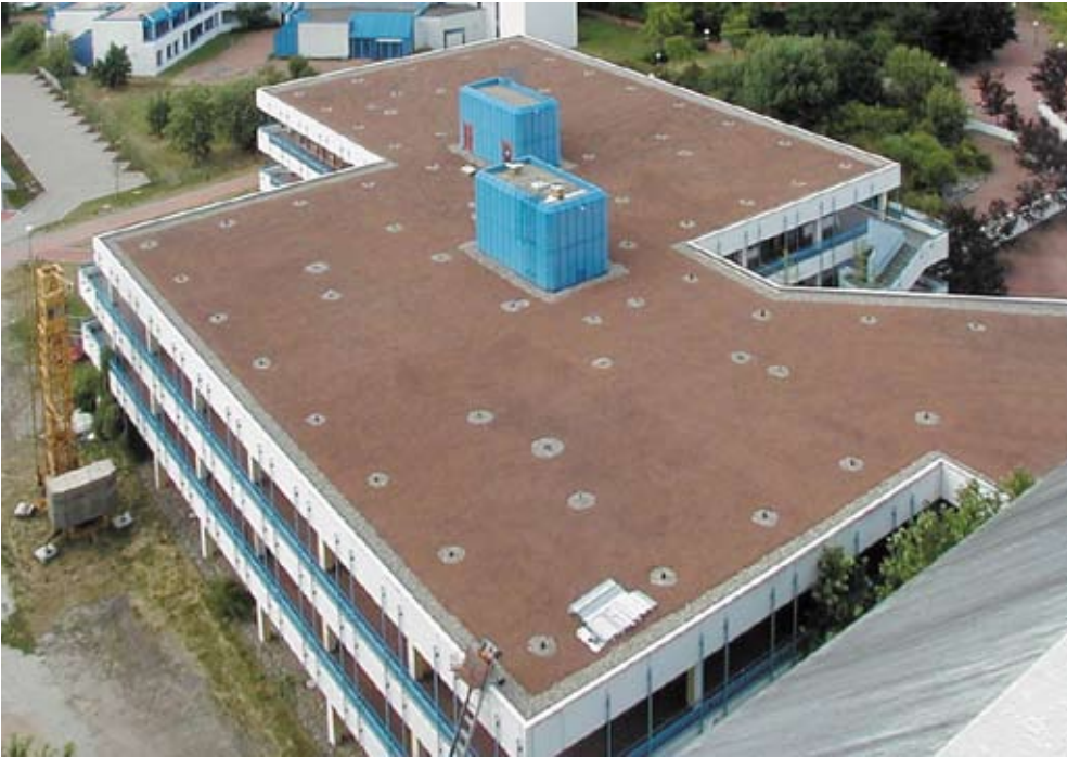
Die instandgesetzte Dachfläche mit Triflex DS, zusätzlicher Dämmung und extensiver Begrünung.
