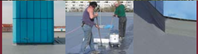
Flachdach des Klinikums saniert
