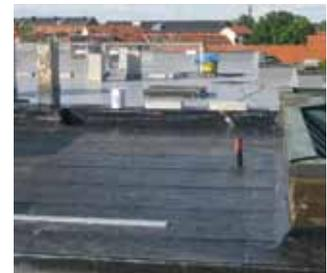
Auf einer Elastomerbitumenbahn über Polystyrol-Wärmedämmplatten wurde das Abdichtungssystem Triflex ProTect aufgetragen. Senkrechte Anschlussflächen und Details wurden mit Triflex ProDetail abgedichtet.
