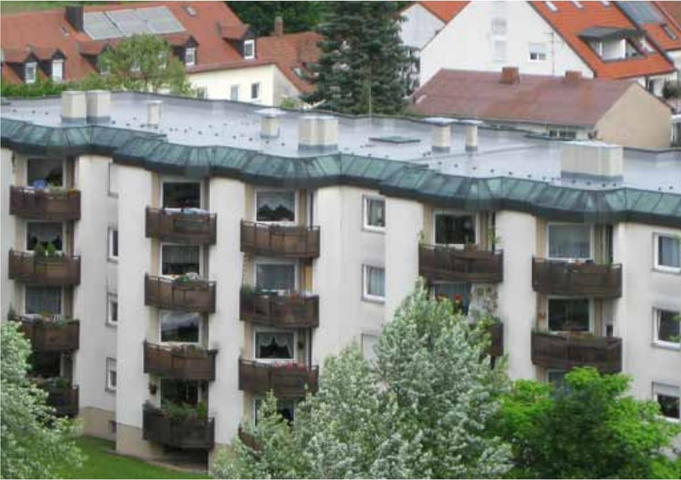
Die UV-beständige Versiegelung mit Triflex Cryl Finish 205 ohne Kiesbedeckung wertet das Gebäude auch optisch auf.
